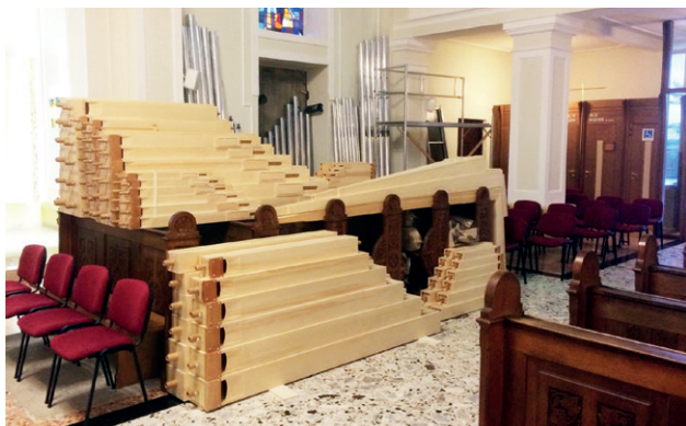
Piščali pripravljene za vgradnjo
