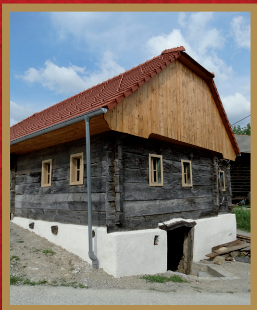
Obnovljena Kovačeva hiša z Grozdetovo spominsko sobo na Gornjih Impoljah, župnija Studenec, maj 2018.
